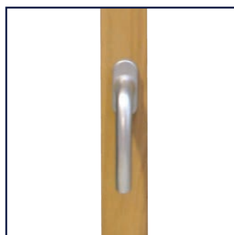
Détail poignée crénone, epoxy
